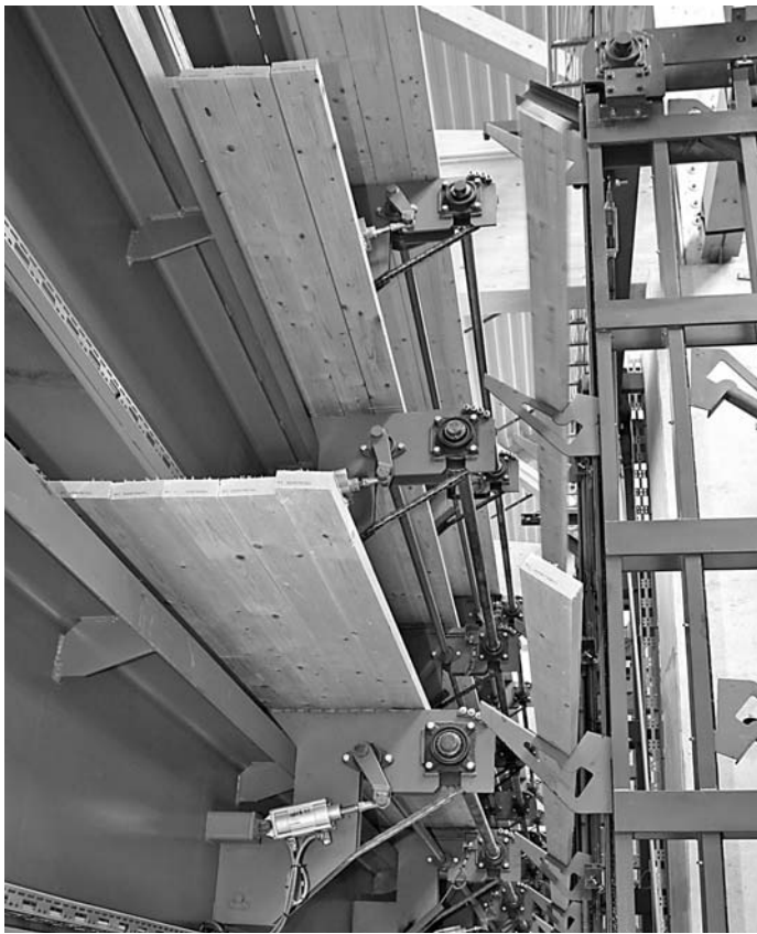
Lamellen-Patentlager beim Etagenlager – dieses wurde 27 m frei tragend ausgeführt
